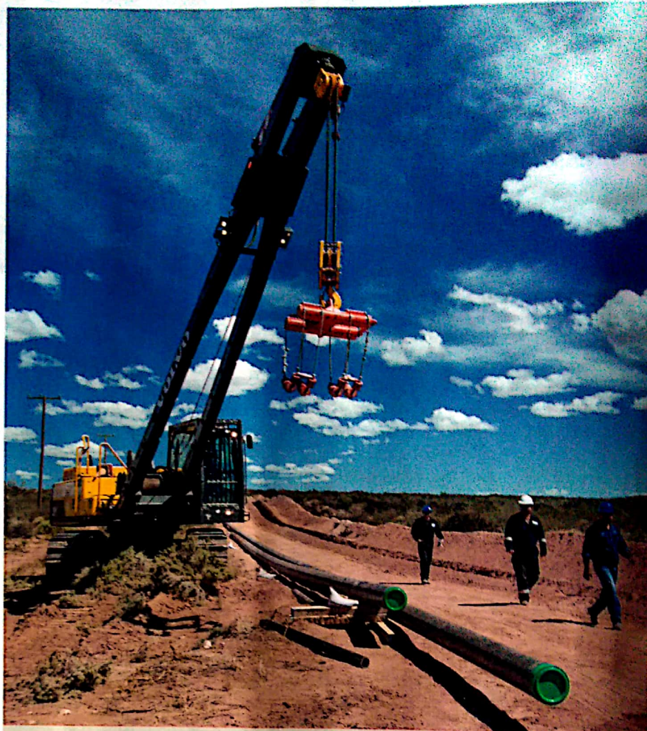
INFRAESTRUCTURA. Tendido de un gasoducto en la zona de Sierra Barrosa.
